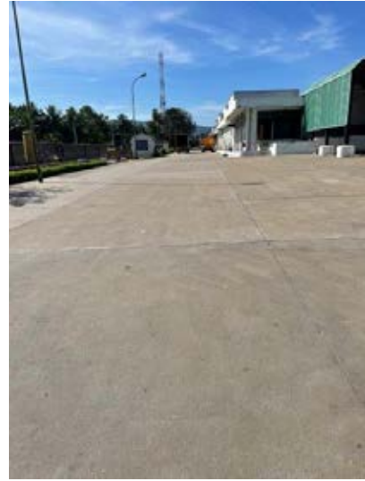
Safe assembly area.JPG
